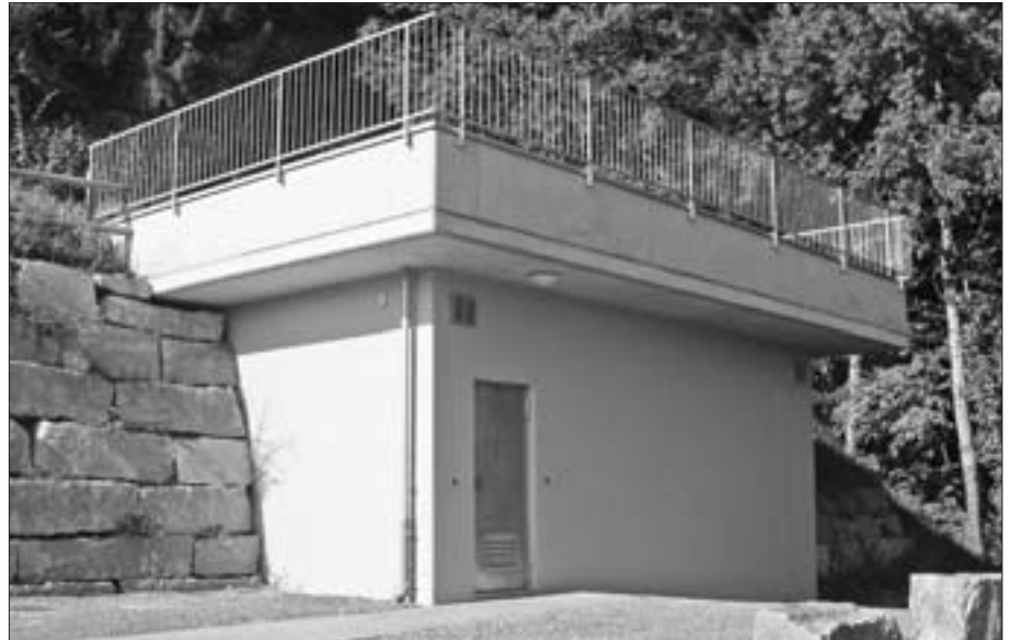
Das neue Wasserreservoir Sonnmatt
