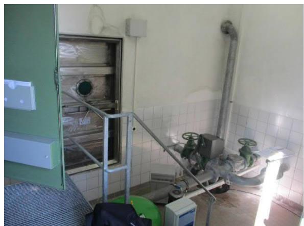
Abb. 2: Bestehender Zustand in der Schieberkammer / Emch + Berger WSB AG, Wasserversorgung Udligenswil
