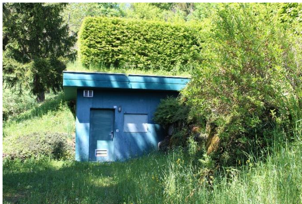
Abb. 1: Ansicht bestehendes Reservoir von aussen / Gemeinde Udligenswil
