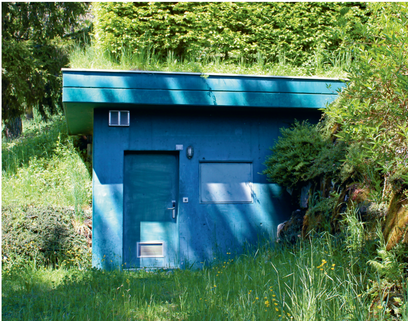
Abb. 1: Bestehendes Reservoir Waldegg
