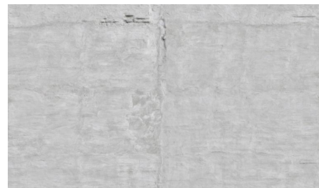
Sockelbereich mit strukturiertem Verputz im Farbspektrum hell Grau
